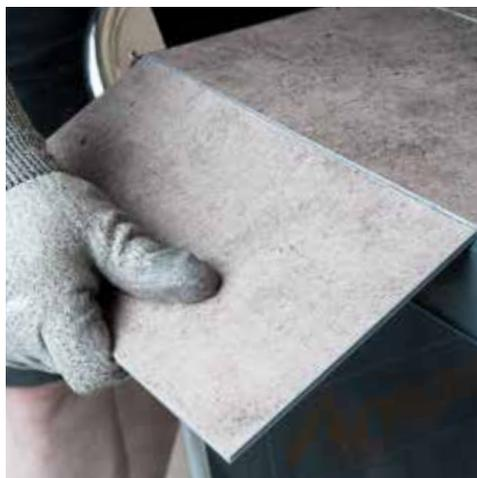
Anschließend an der Schnittkante über einer Auflage (z.B. Tischkante) abknicken und die Kante nach unten brechen.
