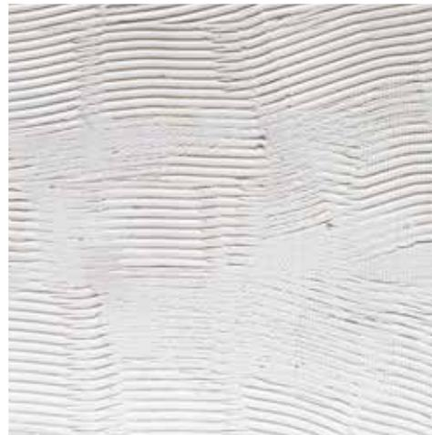
Bitte die richtige Klebermenge auftragen. Der Zahnpachtel muss beim Auftragen des Klebers direkten Kontakt zum Untergrund haben, sonst ist der Kleberauftrag zu dick.
