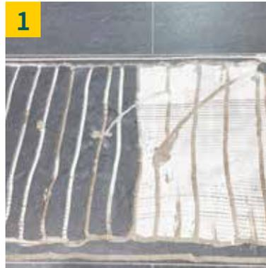
Nun den Innenteil vorsichtig mit einem geeigneten Werkzeug, z.B. einem Stechbeitel, aus dem Kleberbett herauslösen. Dann die Profilteile vorsichtig herauslösen, um die umliegenden Platten nicht zu beschädigen. Jetzt den Untergrund und die Profilseiten von Kleberresten säubern.
