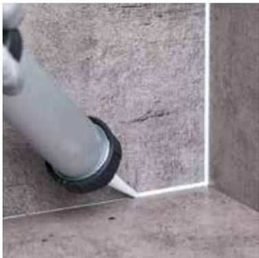
Umlaufende Fugen zu angrenzenden Flächen sollten 5 mm betragen und werden nach einer Trocknungszeit von mindestens 12 h, nach Ende der Verlegung, mit Natursteinsilikon verfugt.
