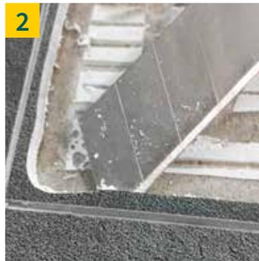
Die Hohlkehlen der Profile an den Längs- und Querseiten müssen bis zur Profilmittte von der Wand / dem Boden entfernt werden, so dass die neue Fliese sich einfach von oben einlegen lässt.
