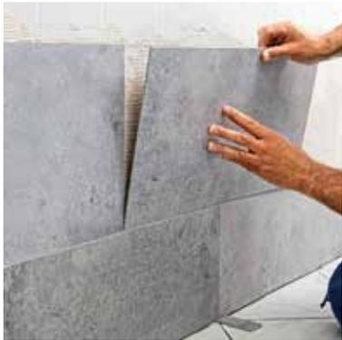
Wir empfehlen die Fugen des vorhandenen Fliesenspiegels grundsätzlich mit CompoundPro und einem glatten Spachtel auszufüllen und min. 12 h aushärten zu lassen.
