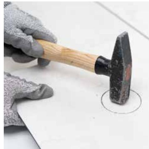
Anschließend kann die angeritzte Kreisfläche mit einem Hammer auf einer hohlen Unterlage von oben herausgeschlagen werden.
