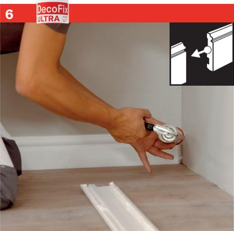
**Use DecoFix Ultra in every joint** | Gebruik DecoFix Ultra in elke naad | Utilisez DecoFix Ultra pour chaque joint | Verwenden Sie DecoFix Ultra bei jeder Naht | Aplica DecoFix Ultra en todas las juntas | Utilizzare DecoFix Ultra in ogni giunta | Użyj DecoFix Ultra w każdym złączu
