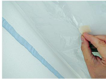
1. Dampfsperre mit Klebeband fixieren. 8 mm dicke **OTTOCOLL® A270-Raupe** auftragen und **1 - 3 Tage ruhen lassen.**
