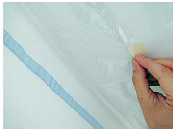
1. Dampfsperre mit Klebeband fixieren. Unmittelbar nach dem Auftragen der **8 mm dicken OTTOCOLL® A270-Raupe** die fixierte Dampfsperre lösen.
