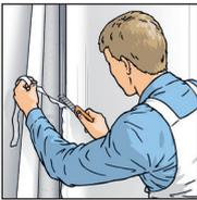
**6.** In Ecken und an Kanten wird nicht überlappend tapeziert, sondern die Trennung erfolgt exakt auf der Kante und nachfolgende Bahn auf Stoß tapezieren.
