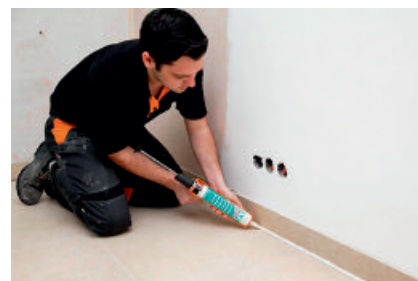
Elastisches Schließen von Boden-Wand-Fugen mit PCI Silcoferm S ohne störende Geruchsbelästigungen während und nach der Verarbeitung.
